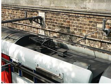
Caténaire rigide sur le RER C.
